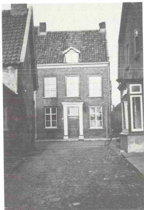
Afb. 4. Gedeelte van de voorgevel van het voormalig gerechtshuis van Woudenberg; Voorstraat 16. (Coll. Rijksdienst voor de Monumentenzorg, Zeist; foto A. van Gent, Barneveld; 1955)
