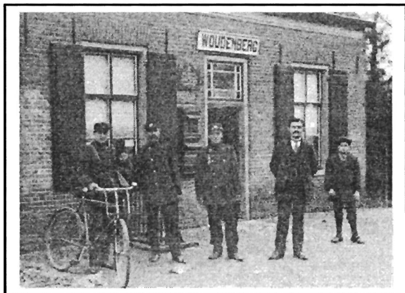
(An)dries van Dijk, de postbode die in 1923 in huis 84 aan de Uitleg woont (tweede van links staande, met snor ) samen met zijn collega's Bart Meerbeek (links) en Dirk van Woerdekom . Rechts kantoorhouder Willem Koudijs . Een foto uit 1916 voor het oude postkantoor aan de Poort. 4
