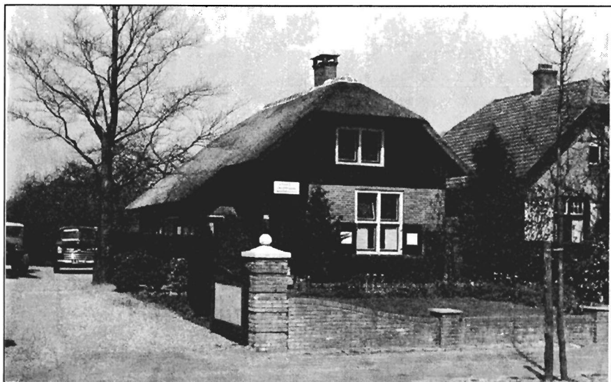
Het kantoorgebouw van het waterschap, Stationsweg 153, Woudenberg. Links hiervan stond Sonnevank. Rechts half zichtbaar het huis van de familie Methorst, Stationsweg 155. (fotocollectieauteur)
