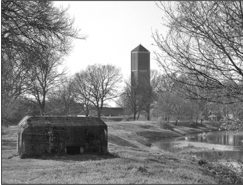
Een gave kazemat op de Grebbeliniedijk nabij de Pothbrug. De waterentoren op de achtergrond. De Grebbelinie is aangelegd in 1741-1746. De kazemat is gebouwd tijdens de mobilisatie in de periode september 1939 - mei 1940. (Foto W. de Greef, maart 2009)
