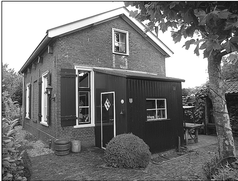
Voormalig spoorhuis nummer 13, aan de Laagerfseweg in Woudenberg dat door de huidige eigenaar prachtig is opgeknapt. (foto JvO)
